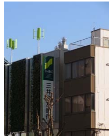
(国道2号線からの外観写真)
