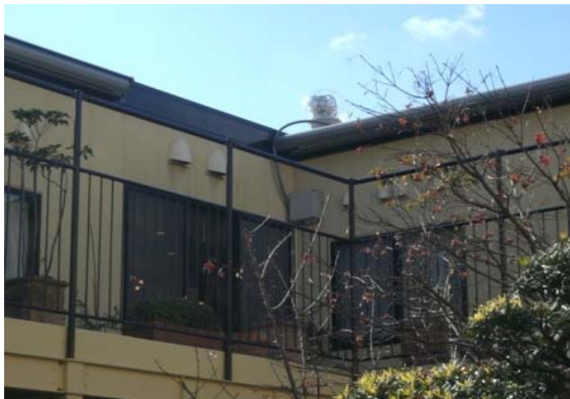
【2F 屋上に設置】
