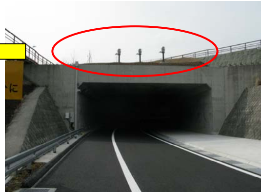
【本線へのトンネル】
