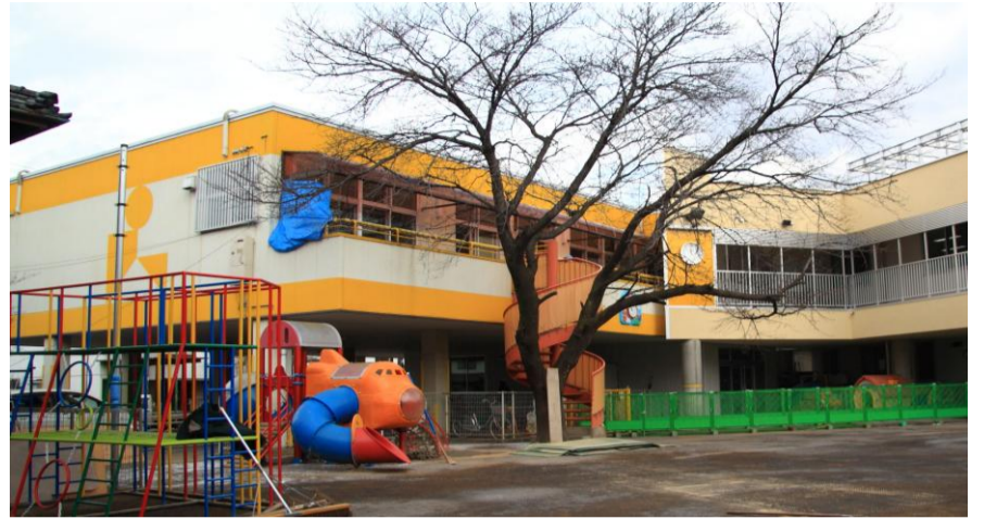
【改修工事中の園庭】
