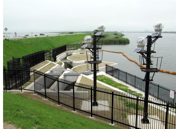
常陸利根川水門魚道
